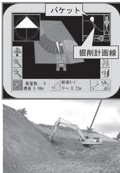
図一2 情報化施工のモニタ画面
