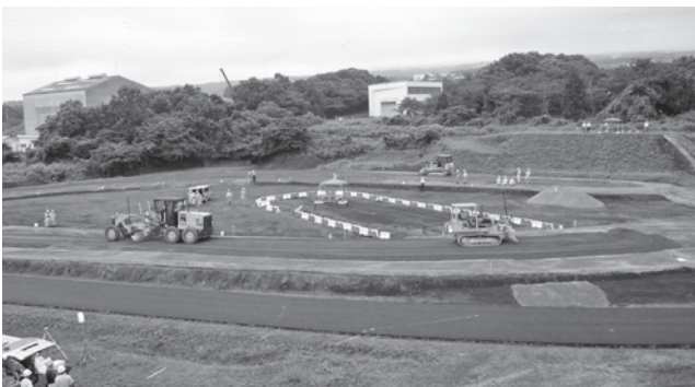
写真一 2 情報化施工実習状況
