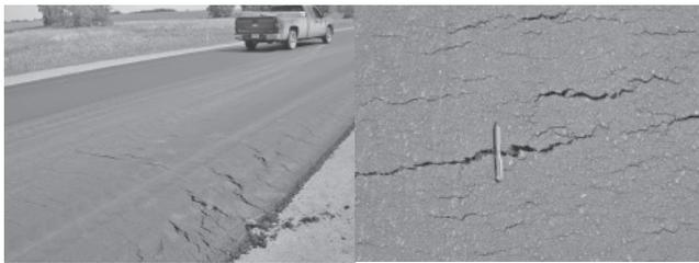
写真-3 CCVの低い路盤上に施工されたアスファルト層の破壊
