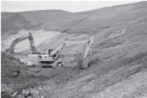
写真一五 切取法面仕上げ状況
