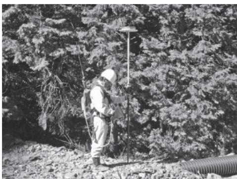
写真-2 3D-NAViによる測量状況
