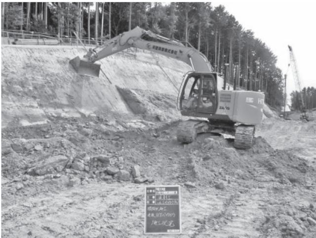
図一七 法面バケットによる法面整形
