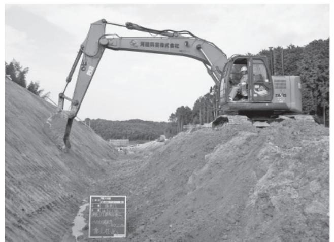
図-6 通常バケットによる法面整形
