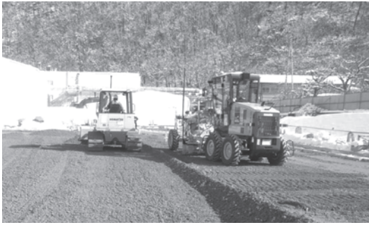
写真—2 3D-MC ブルとの組み合わせで施工精度を高めている
