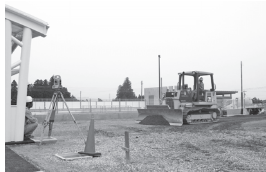
写真-1 3D-MC システムの施工事例
