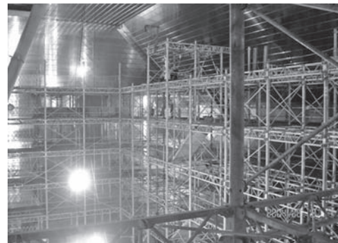
写真一四 最上階足場解体風景
