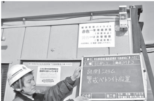
写真一1 警報機（回転灯）設置状況
