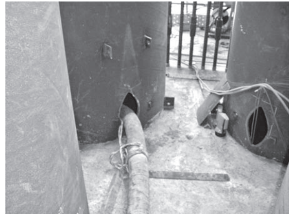
写真一3 鋼管中詰コンクリート打設状況
