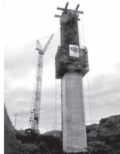
写真-1 施工状況全景
