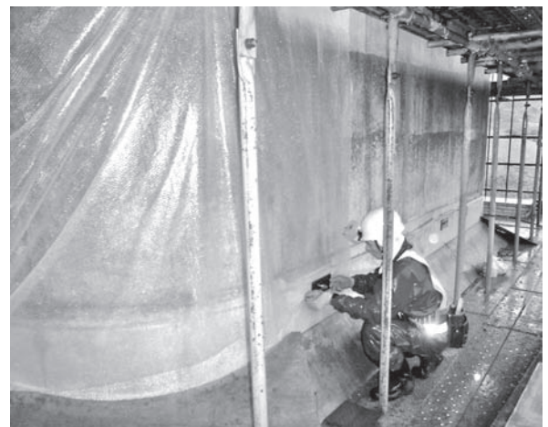
写真一4 気泡緩衝材巻付け状況
