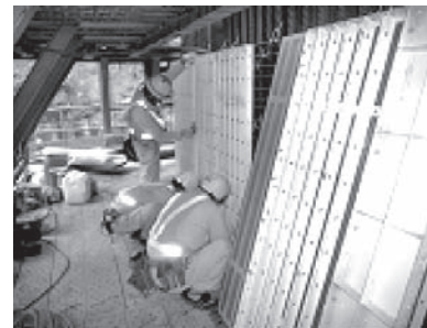
写真-2 HSF装置内での型枠組立状況
