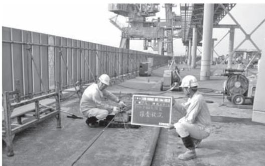
写真-4 「曲がり削孔」探査孔からの磁気探査
