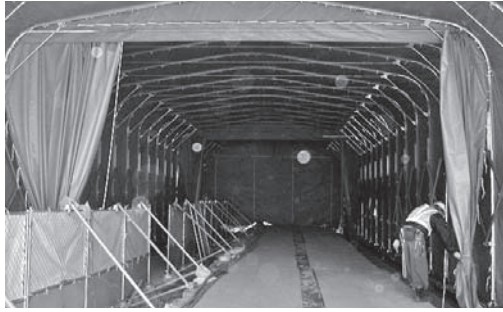
写真一 2 間仕切り膜取付状況
