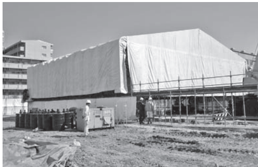
写真一 3 テント嵩上げ状況
