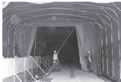
写真—1 間仕切り膜取付状況
