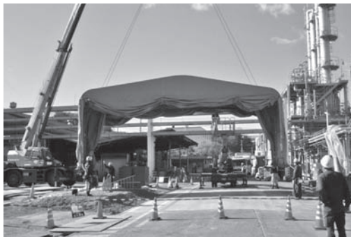
写真一 5 テント移動状況
