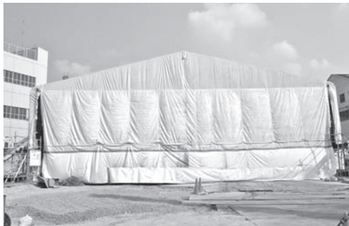
写真一 4 テント嵩上げ状況
