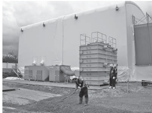
写真一 7 集塵機設置状況
