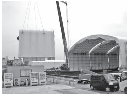
写真一 6 テント移動状況
