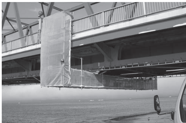
写真-18 厚岸大橋
