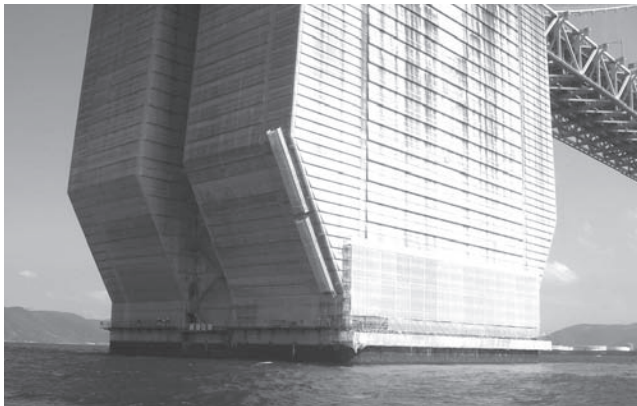
写真-11 瀬戸大橋アンカレージ
