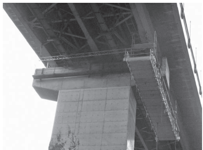
写真-4 滝沢川橋（次径間へ盛替中）
