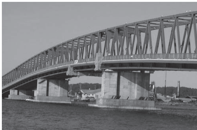
写真-17 厚岸大橋
