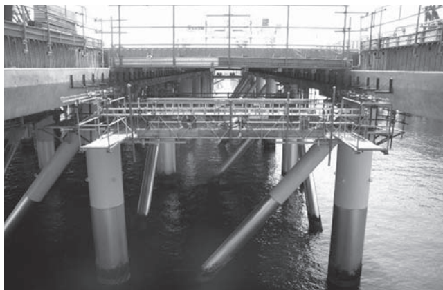
写真-15 東京国際空港 D 滑走路
