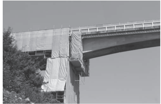
写真-13 名田跨道橋
