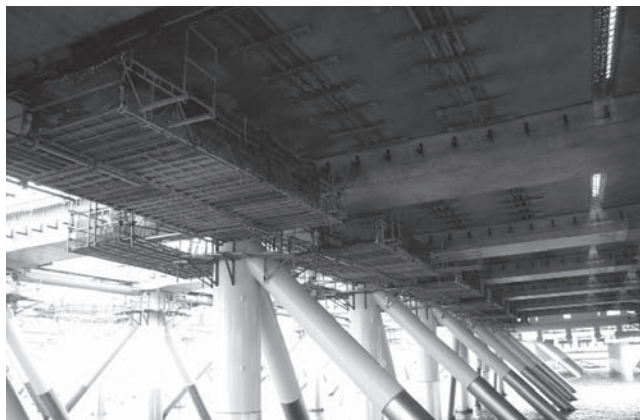
写真-14 東京国際空港 D 滑走路
