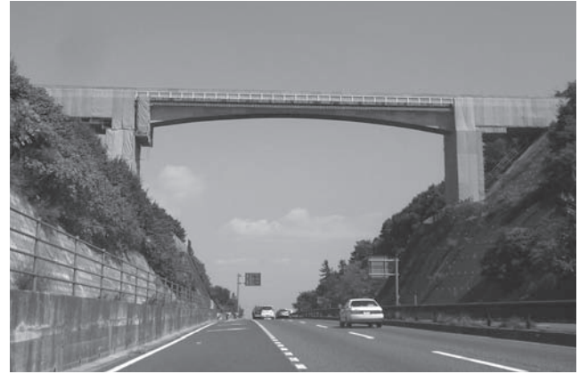
写真-12 名田跨道橋
