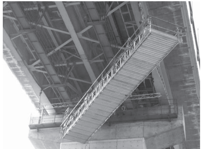
写真-3 滝沢川橋（ラック足場移動床旋回中）
