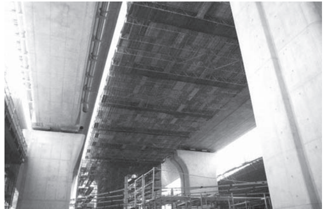
写真—8 第二京阪国道
