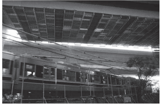
写真—7 第二京阪国道
