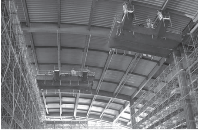
写真-9 新ドーハ国際空港
