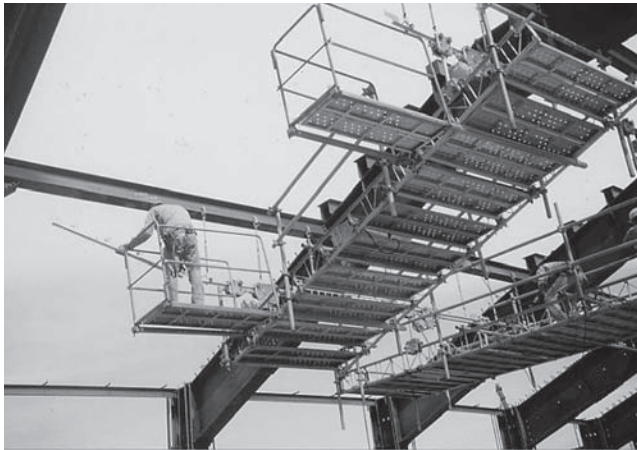
写真一 手摺り内での作業状況
