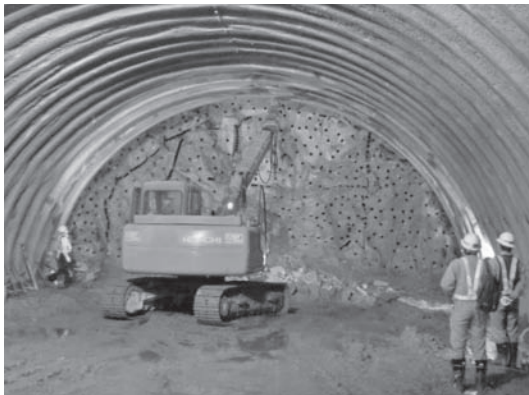
写真—3 安永川トンネル
