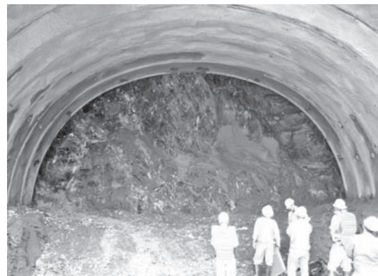
写真一 2 第二伊勢道路 4 号トンネル
