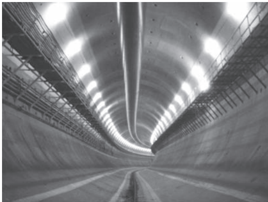
写真一5 本掘進工における本線シールド坑内状況
