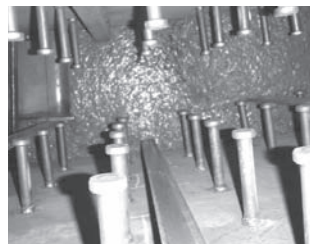
内部コンクリートの充填
