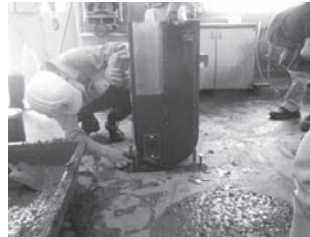
コンクリートの流動性確認試験
