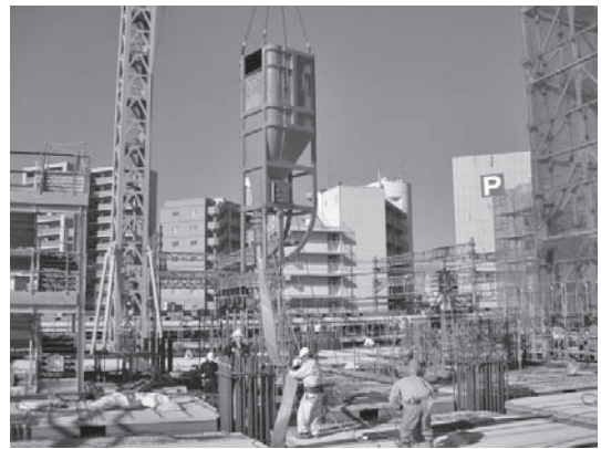
写真二 バケット打設状況
