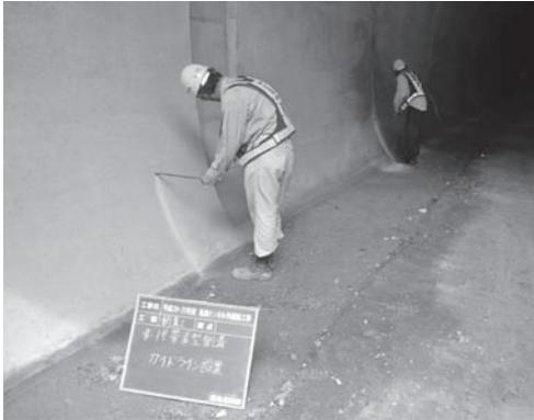
写真—1 センサーラインの設置状況
