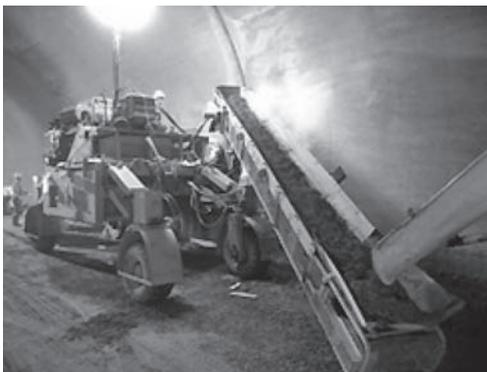
写真—3 コンクリート投入状況
