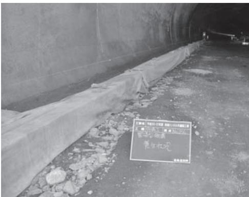
写真一8 養生マットによる養生状況
