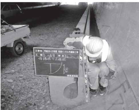
写真一9 管渠型側溝設置完了
