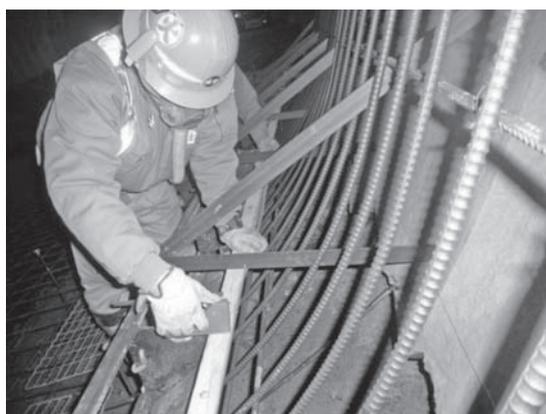
写真-2 シート取り付け (タッカー使用) 状況
