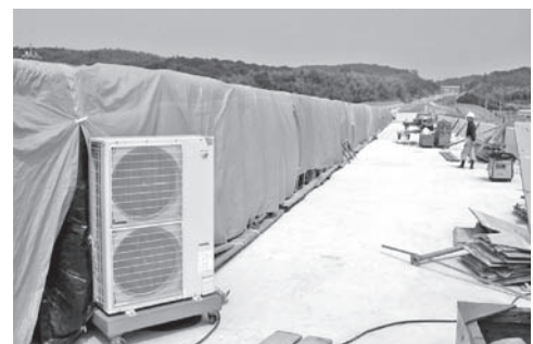
写真一6 養生システムの設置状況
