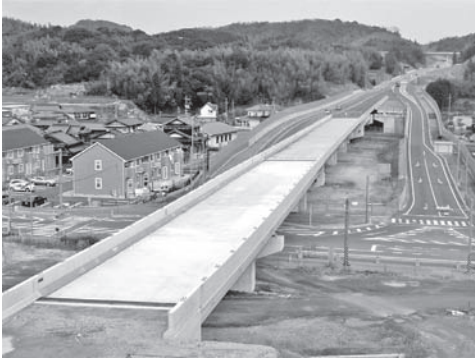
写真一七 完成した上部工（竣工時にひび割れは確認されていない）
