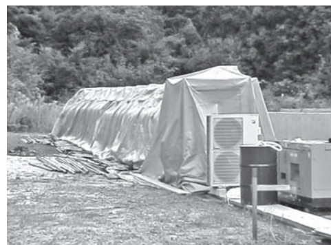
写真-1 養生システムの試験
