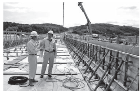
写真一5 養生システムを採用した国道バイパス上部工
