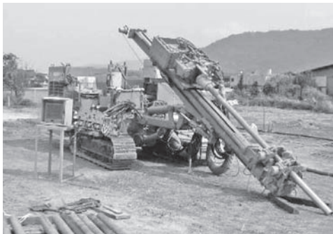
写真—4 振動機付き施工機
