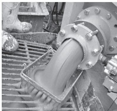
写真—3 流動化砂（プラント吐出口）
