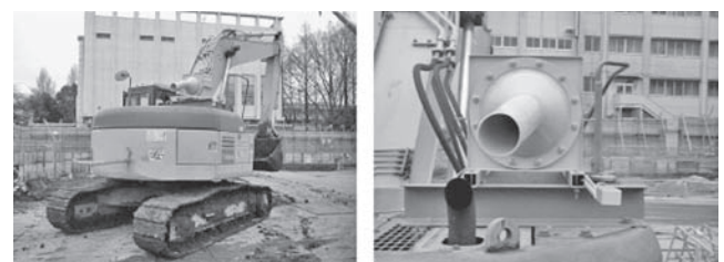
写真一2 2次音源およびエラーマイク設置状況(建設現場)
