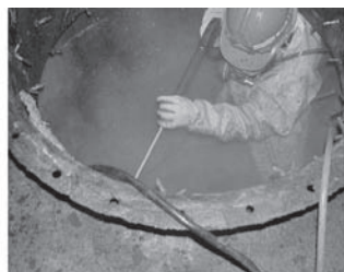
写真一3 洗浄状況
