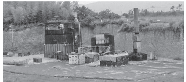
写真-1 解体前の焼却施設全景
