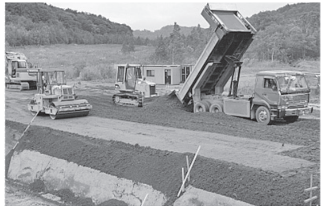
写真一 4 敷き均し・転圧
