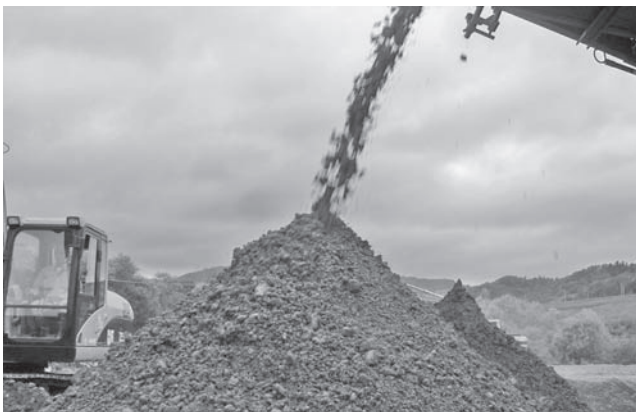
写真一 3 CSG排出直後
