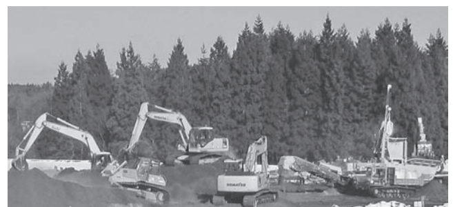
写真一5 道路改良工事で稼働事例
