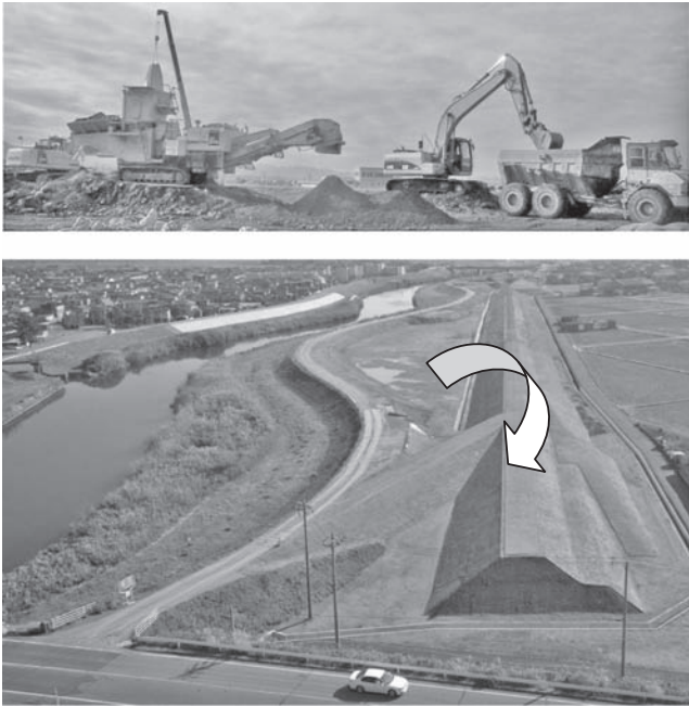
写真一六 河川築堤工事での稼働事例 上：堤防内で稼働 下：築堤後
