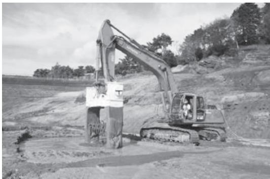
写真—2 DAM機による攪拌状況
