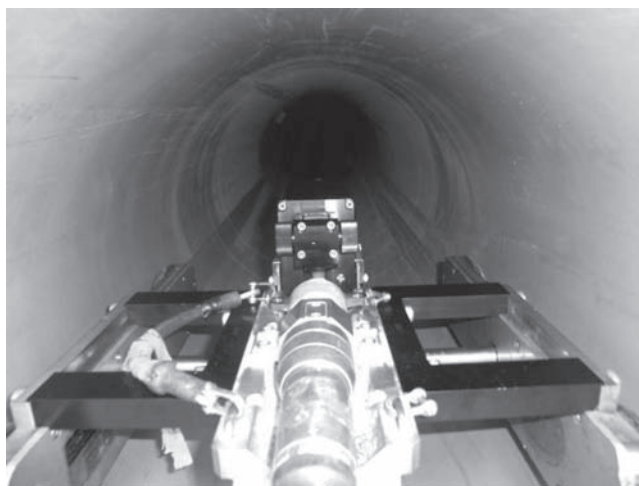
写真一1 計測ロボットの計測状況
