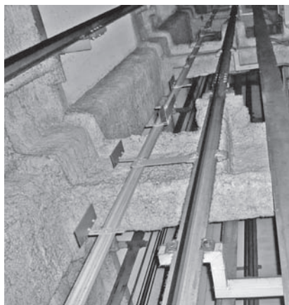
写真-1 エレベーターシャフト内部
