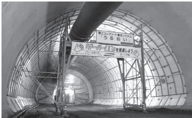
写真-1 うるおい養生全景
