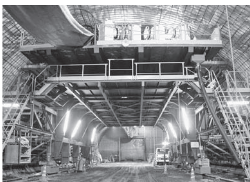
写真一1 セントル全景（マルチ工法搭載）
