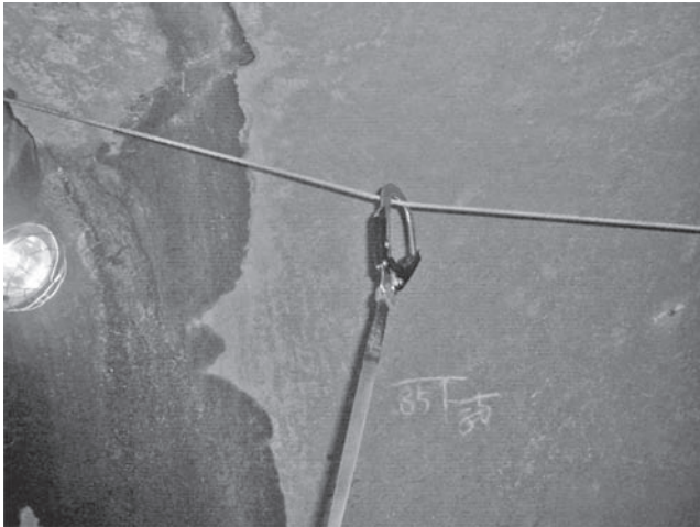
写真一2 安全器具の例（親網設置状況）
