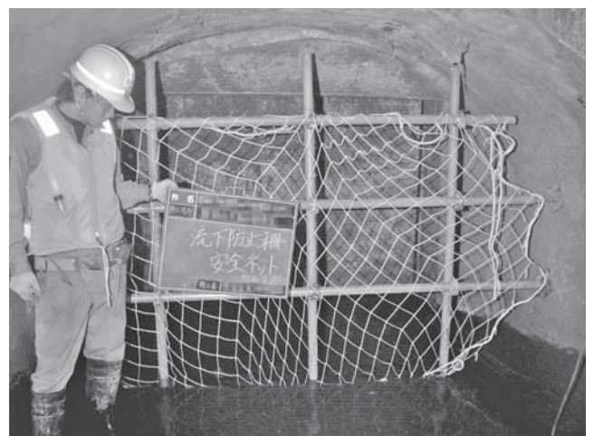
写真—1 安全対策の例（流出防止柵）
