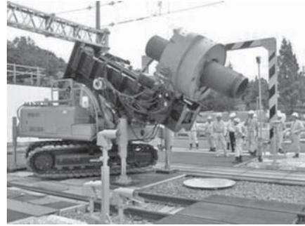
写真—8 線間杭打設再現
