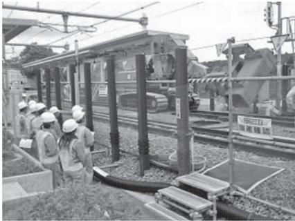
写真—4 線間橋脚建込み再現
