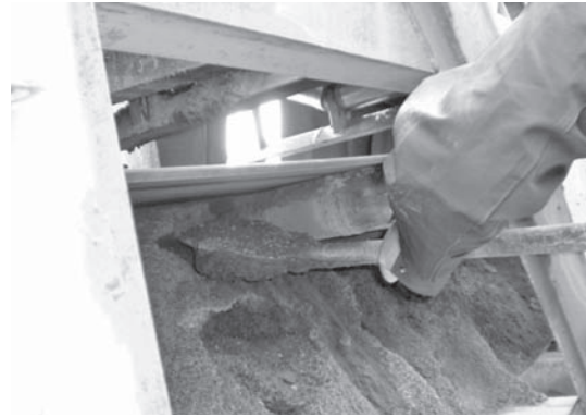
写真-4 リターンローラー部分での作業
