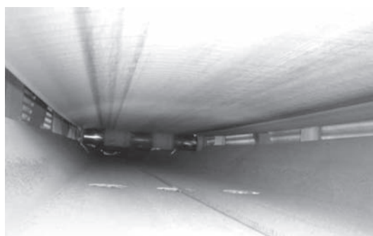
写真一〇 スクレパーにより掃除された状況
