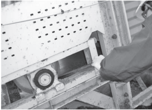
写真-3 テールプリー部分での作業
