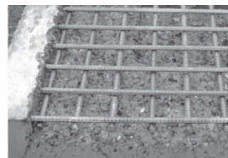
写真—2 鉄筋以深までの除去
