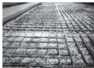
写真—1 鉄筋までの除去
