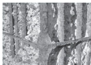
写真—3 塩害部の除去
