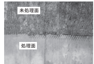
写真—6 表面処理（橋脚補強）
