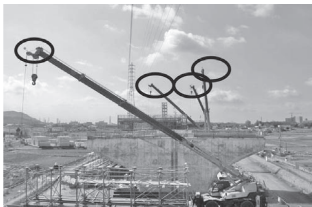
写真一4 球面リフレクタ取付けクレーンによる施工状況
