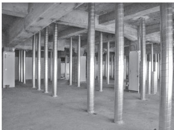
写真一2 床補強用サポート設置状況
