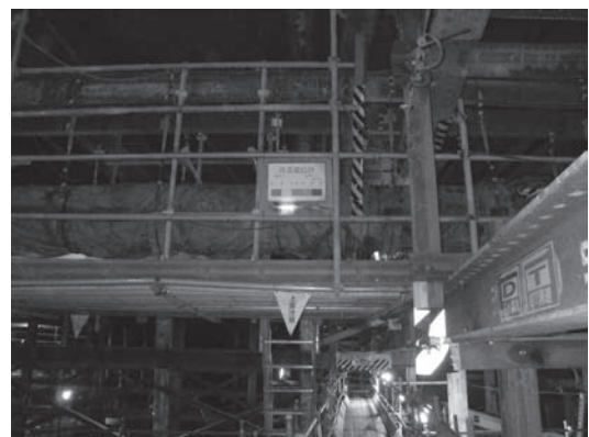
写真—5 光る変位計 誰でも安全通路から確認できる
