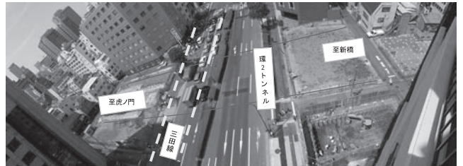
写真-1 着手前全景
