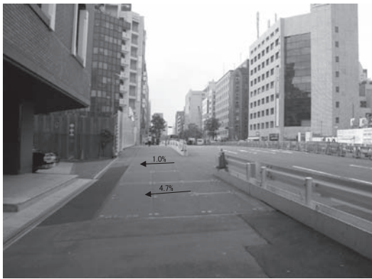
写真—3 覆工架設
