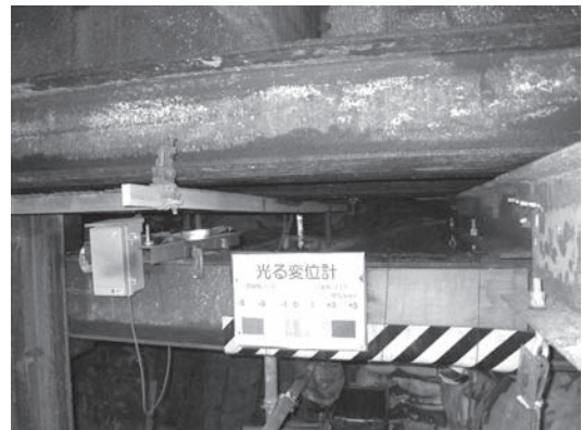
写真—4 光る変位計：計測箇所
