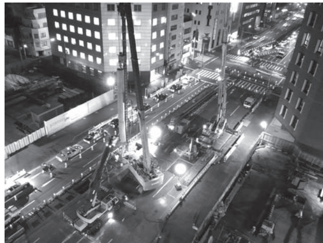
写真-2 杭打ち状況
