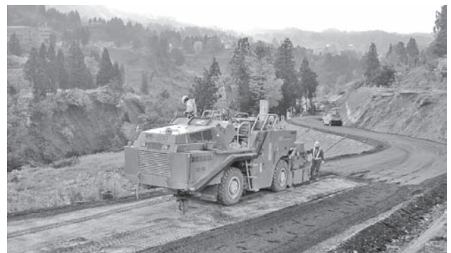
写真—1 新潟県中越地震災害復旧工事での作業状況
