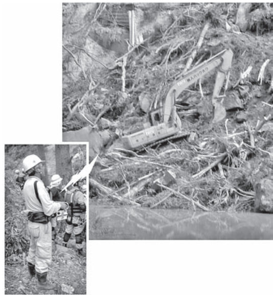
写真—4 無人化施工機械の使用状況
