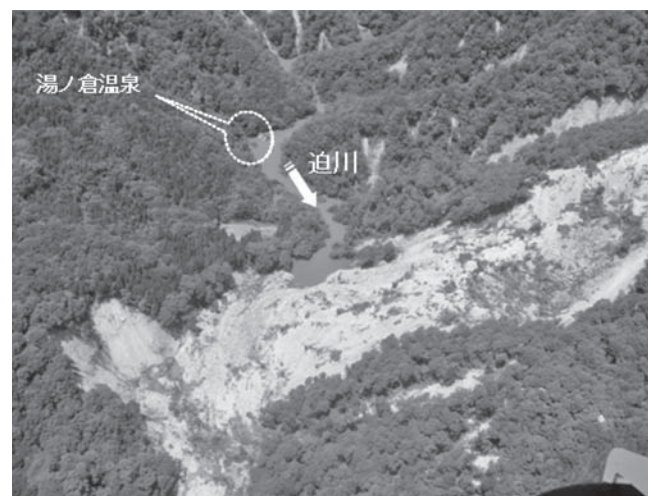
写真—1 湯ノ倉温泉地区の河道閉塞状況
