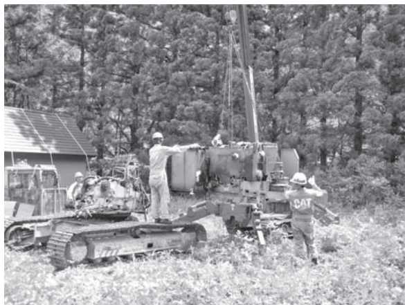
写真—3 油圧ショベル組立の状況
