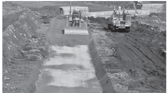
写真-4 敷均し状況
