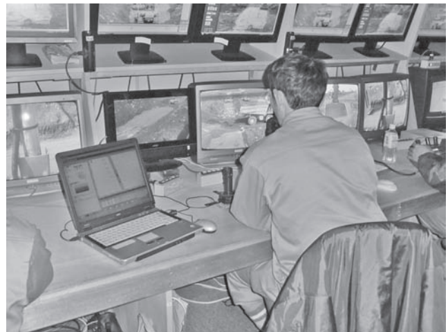
写真-5 敷均し操作状況
