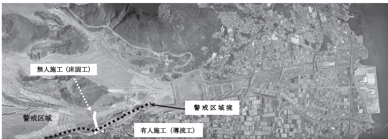
写真-2 施工区分
