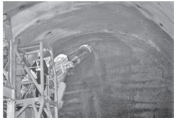
写真-1 自動化掘削切羽状況
