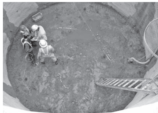
写真一八 NRC 破碎前
