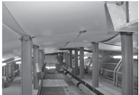
写真—1 温ぬく養生状況 (例：セントル天端部)
