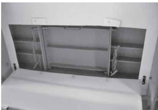
写真-4 側フォーム部（打設窓箇所）
