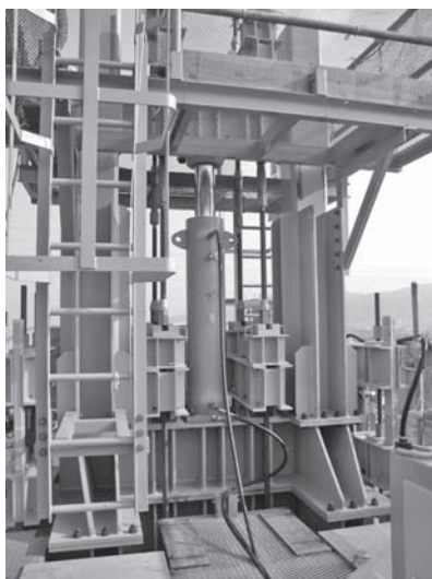
写真—4 吊り上げ用ジャッキ
