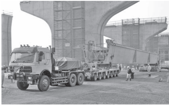
写真-1 U桁場内運搬状況
