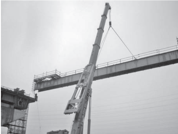
写真—2 ガーダー移設状況
