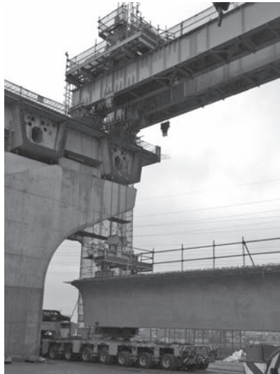
写真一七 U桁架設状況
