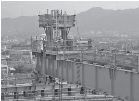
写真—3 リフティング装置
