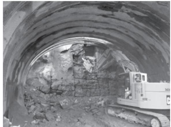
写真-5 ブレーカ破岩状況
