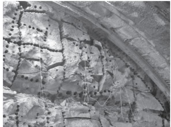
写真-4 割岩状況 (高圧ガス破碎剤)
