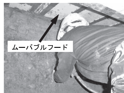
写真-7 ムーバブルフード下の掘削
