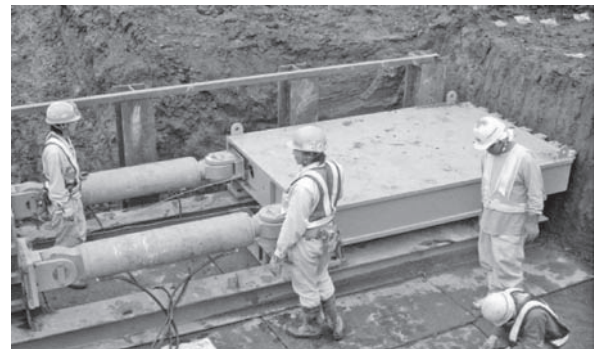
写真—3 洪積シルト層（関東ローム）貫入実証実験状況
