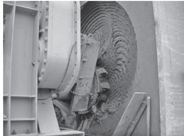
写真-5 硬質地盤掘削性能確認実験状況
