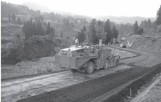
写真—4 新潟県中越地震災害復旧工事（新潟県古志郡山古志村）
