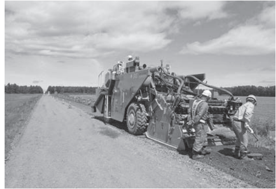
写真—6 大規模農道での施工状況
