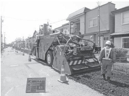
写真—5 市街地での施工状況
