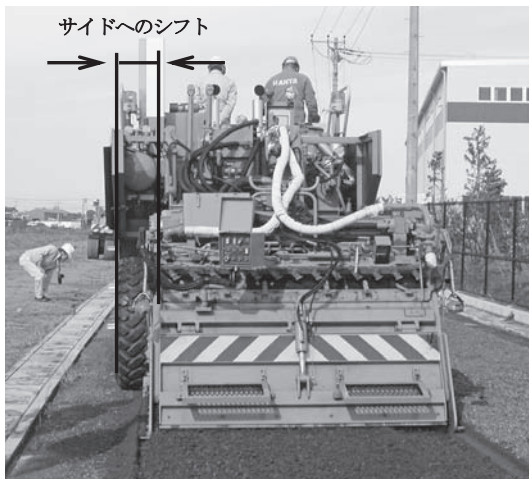
写真一 3 ロータのシフト状況
