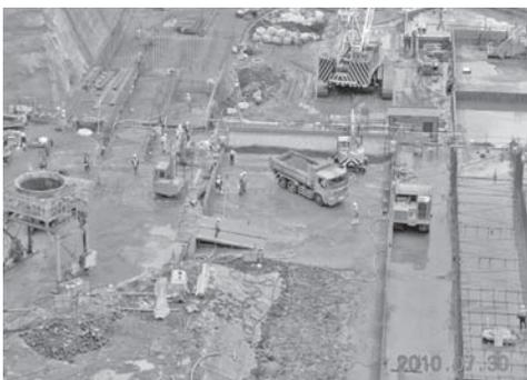
写真一九 堤体部打設状況
