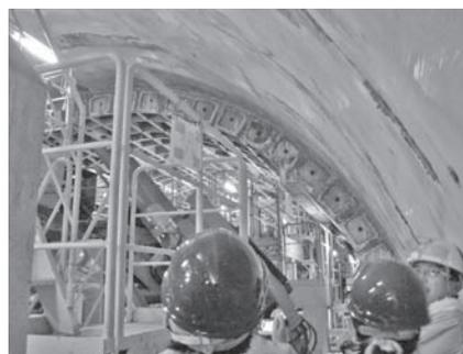
写真—1 後端部型枠の状況
