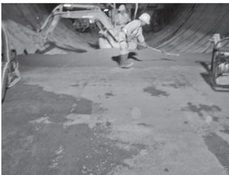
写真—5 一次インバート施工状況
