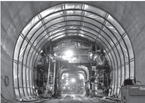
図-1 ラップユニット式覆工コンクリート養生工法全景
