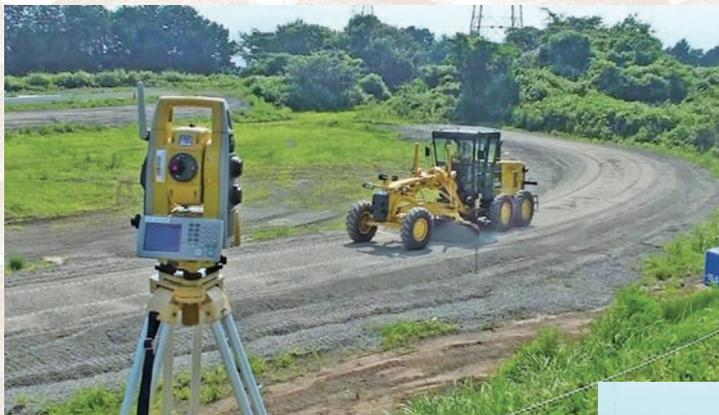
⇄自動追尾式 TS, GNSS を用いたマシンコントロールモータグレーダを用いた路盤整形工のマシンコントロールでは高精度な自動追尾式 TS が用いられることが多い。現場の丁張りはほとんど不要である。バックホウのマシンガイダンスでは、オペレータのモニタにバケット刃先位置と法面設計が表示されている（自動制御はされていない）。
