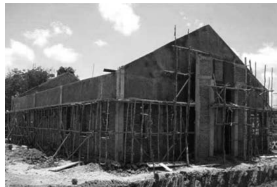
写真一 8 分析室建設中
