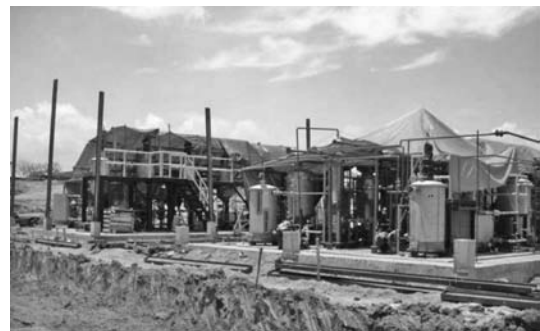
写真一 7 パイロットプラント建設中
