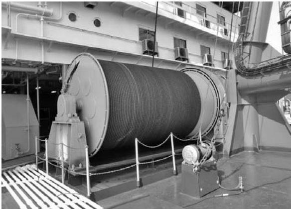
写真一三 昇降ウインチ
