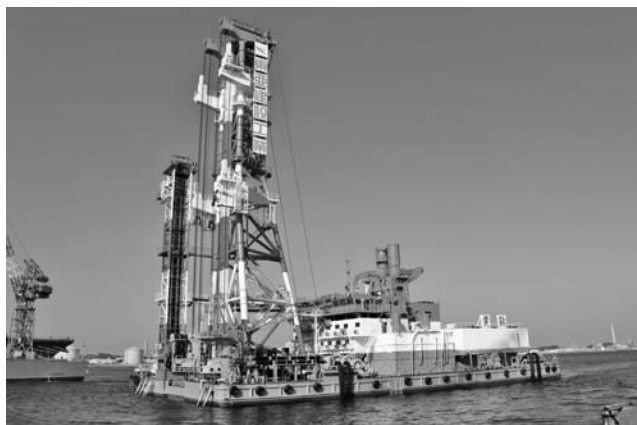
写真—1 深層混合処理船「黄鶴」
