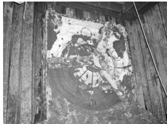
写真一1 ハーモニカマシンの到達状況
