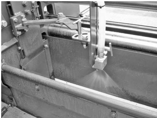
写真一六 散水状況
