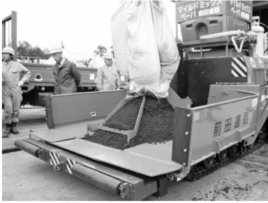
写真—8 フレコンバック貯蔵合材の施工状況
