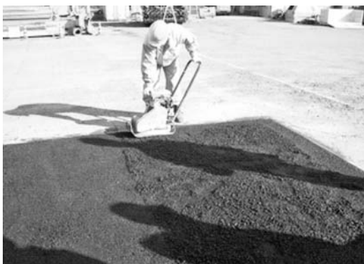
写真一4 転圧状況
