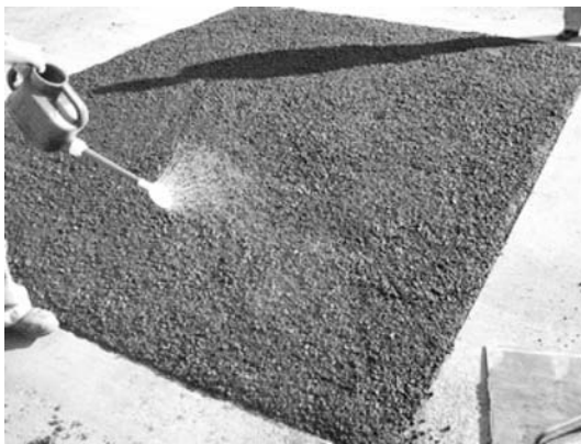
写真一3 散水状況
